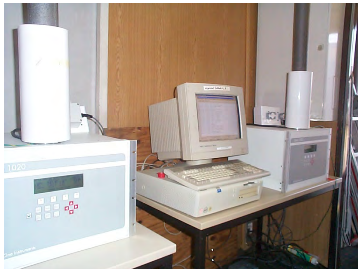
Abbildung 6: Messgeräte BAM-1020 in Messstation
